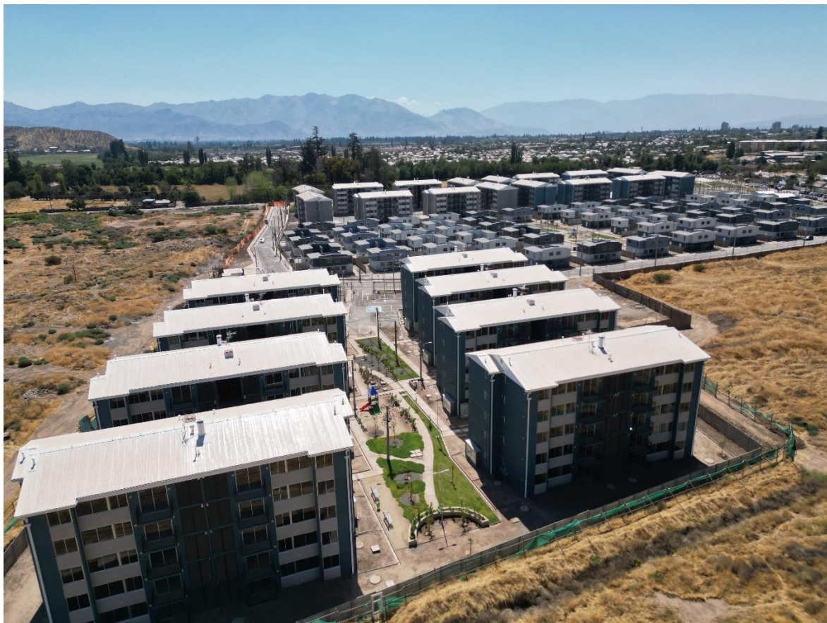
Megaproyecto Habitacional DS49 Brisas de Los Andes
