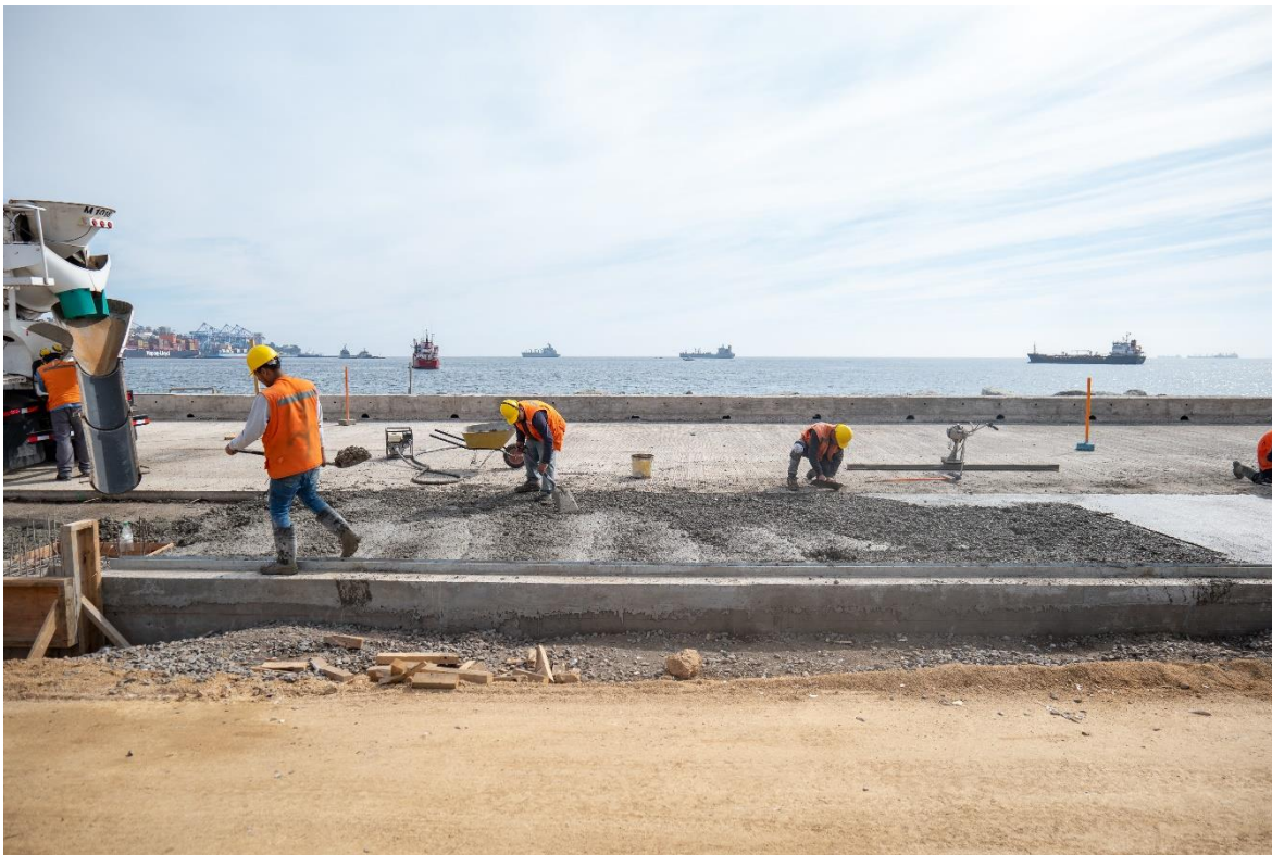
Avances de Obras Parque Barón.
